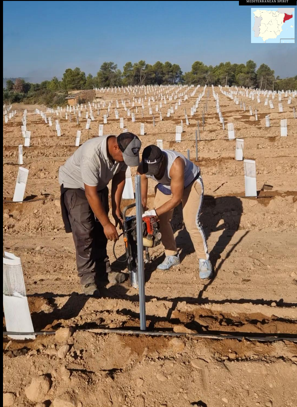
Installing suport estrutura
