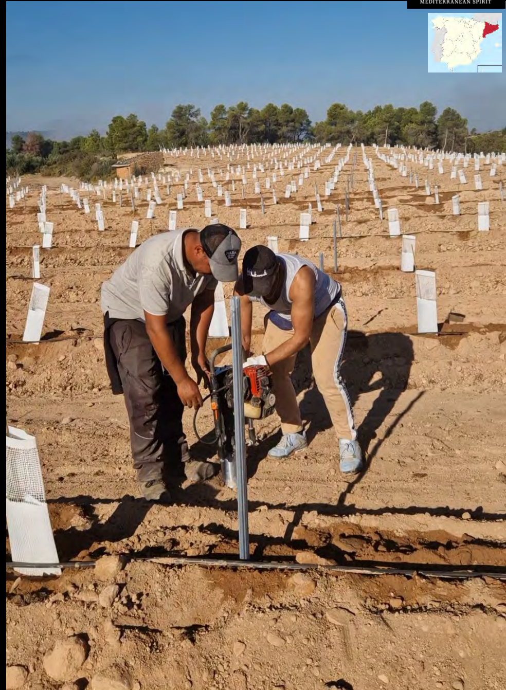
Installing suport estrutura
