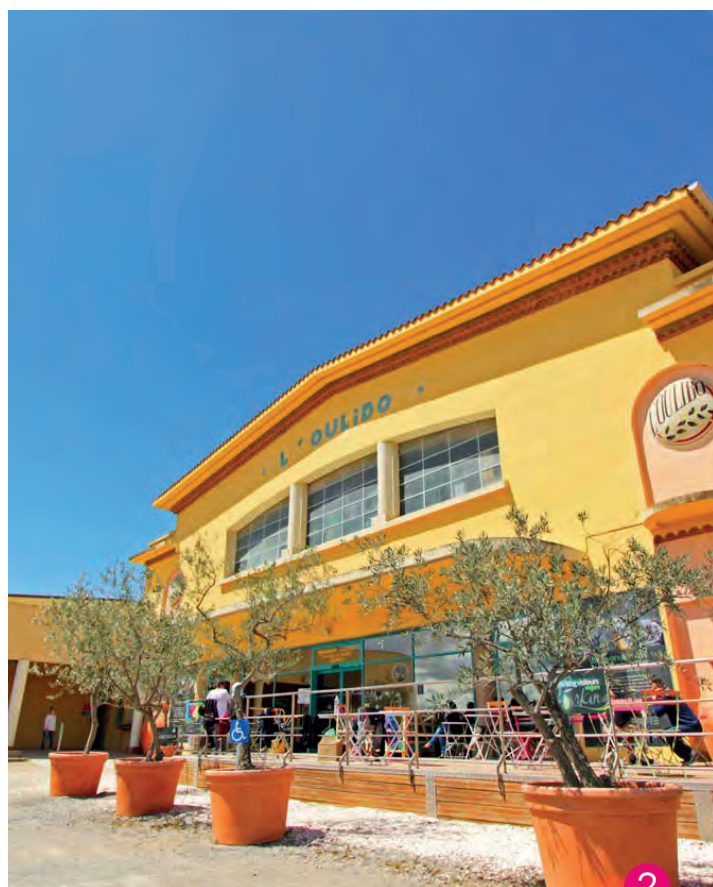
Photo 2 : le bâtiment principal de l'Oulibo a fait appel à la technique du béton armé, de forme trapue, ce qui lui donne un aspect d'indestructibilité.
